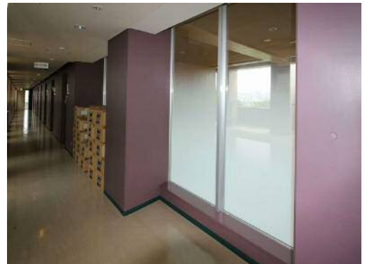
② テラス2改修後（廊下側視線） Terrace No. 2 After renovation (Corridor side view)
